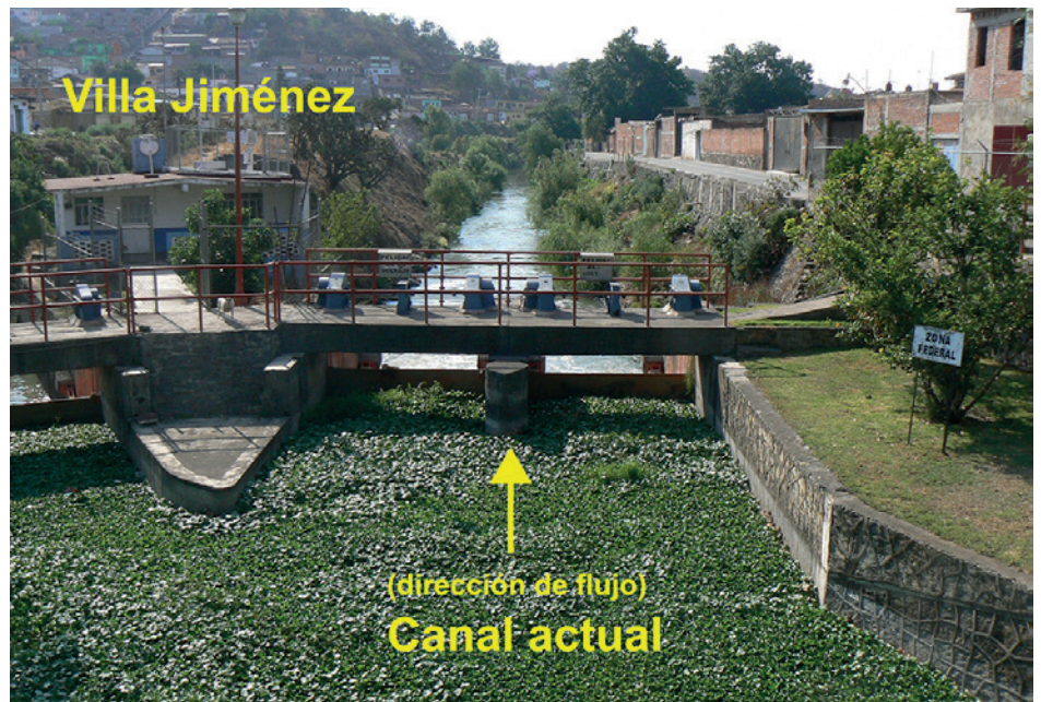
Figura 20: Canal de Villa Jiménez (Parada 6) que sirvió para drenar el lago de Zacapu hace más de 100 años (flecha indica dirección del flujo). Foto Claus Siebe.
